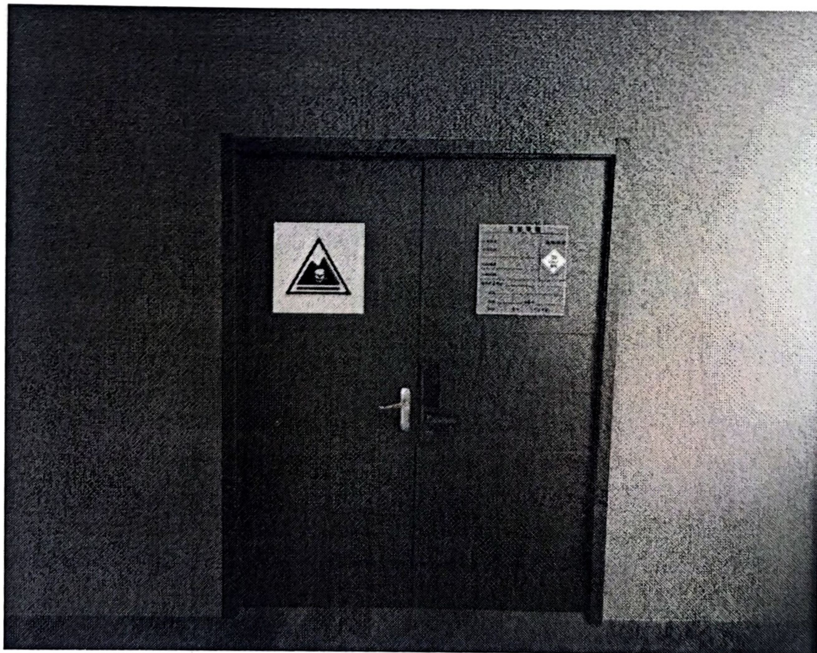
图 4.1-1 危废仓库外部
